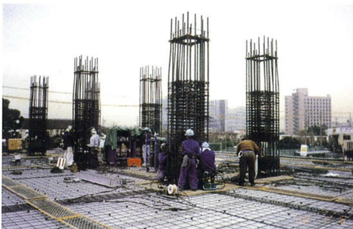
先組み工法（柱）
