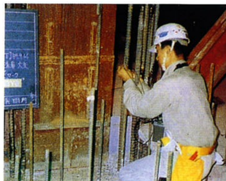
6 超音波探傷検査
