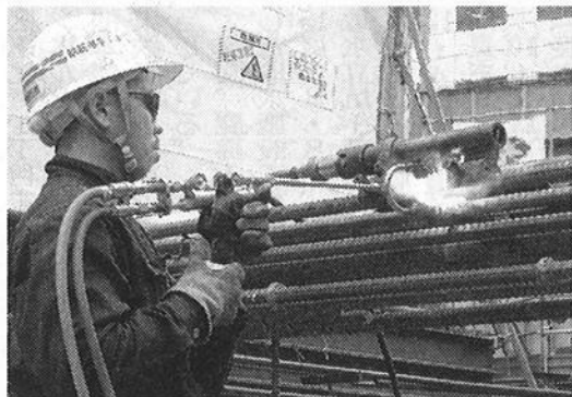
松栄工業が、都内のマンション建設工事で施工している
